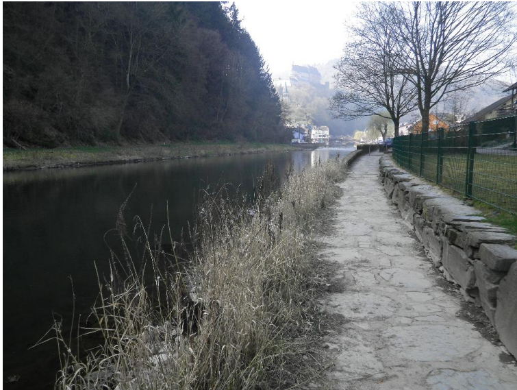
Bebauung mit Freifläche
