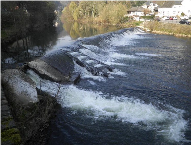
Absturz mit Fischtreppe
