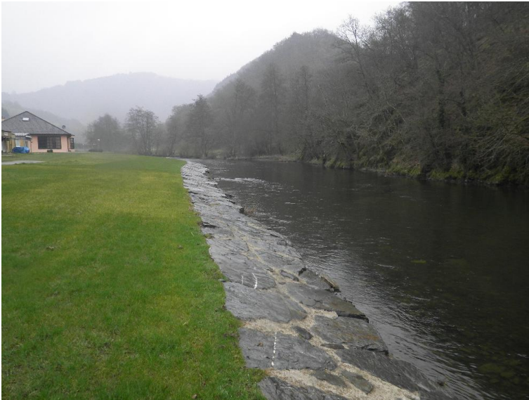
Bebauung mit Freifläche
