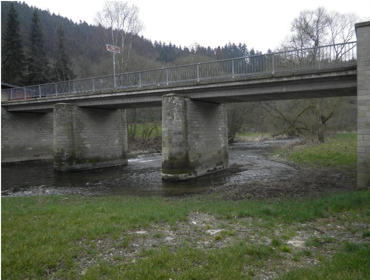
Durchlass; Ufer unterbrochen
