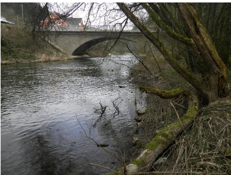
Durchlass; Ufer unterbrochen
