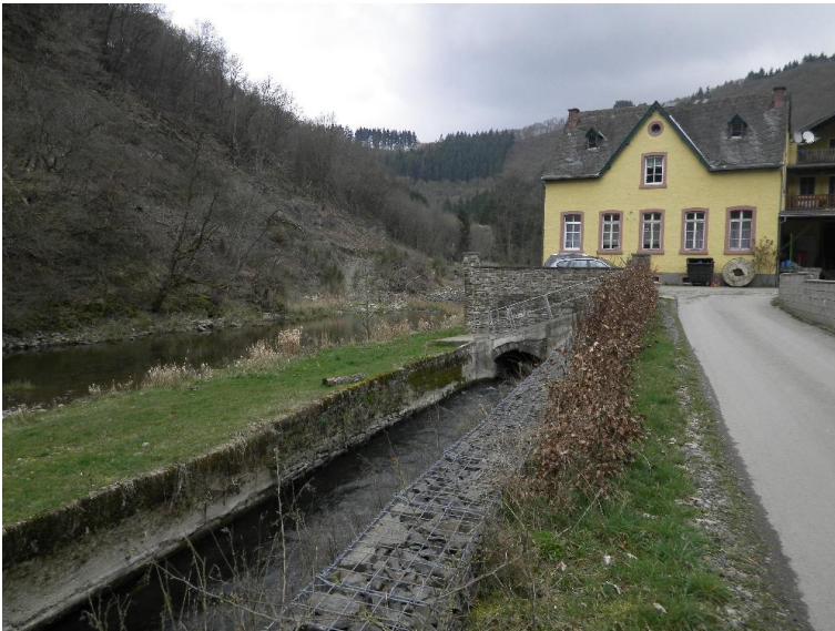
Bebauung mit Freifläche
