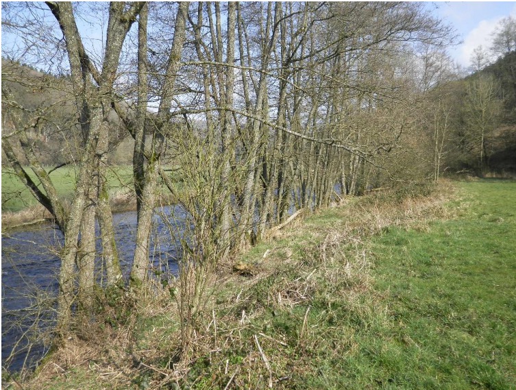
Lebendverbau durch dichten Baumbestand
