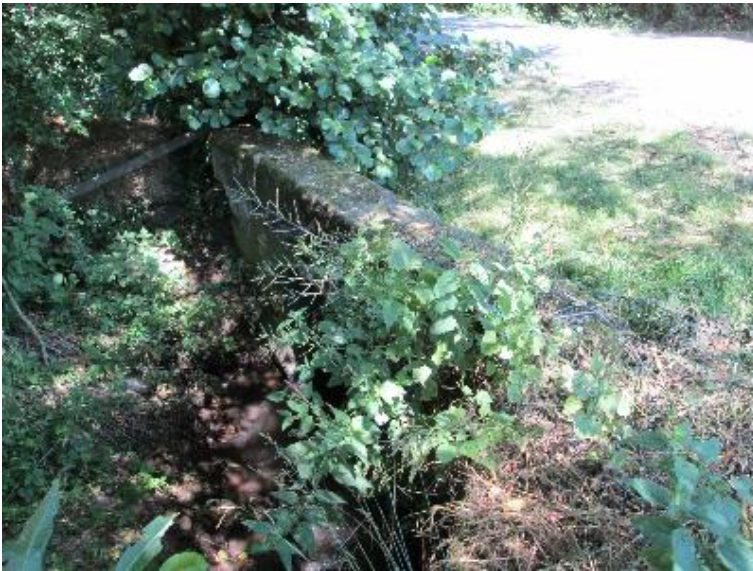
verrohrt bzw. ueberdeckt
