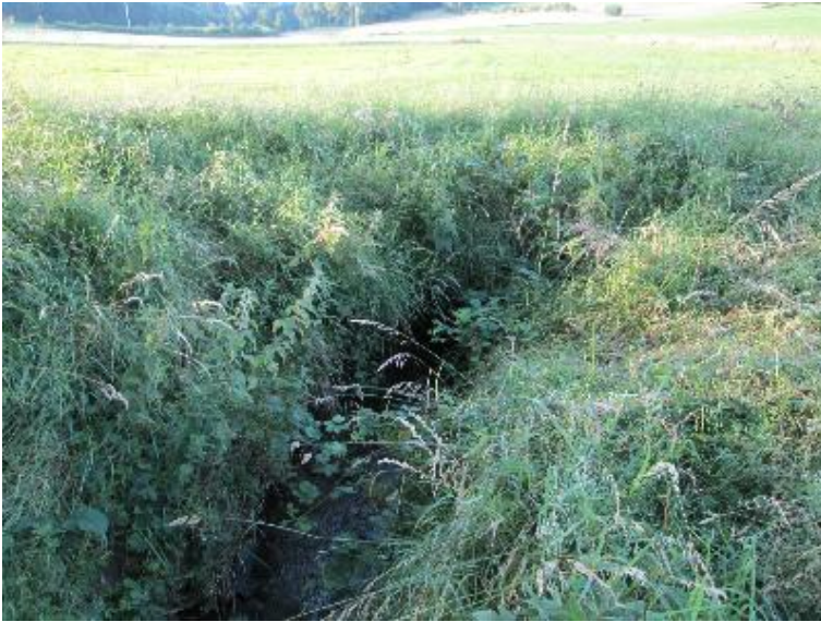
Raue Gleite - verrohrt bzw. ueberdeckt
