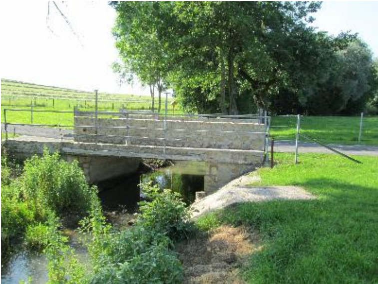
Durchlass; Ufer unterbrochen
