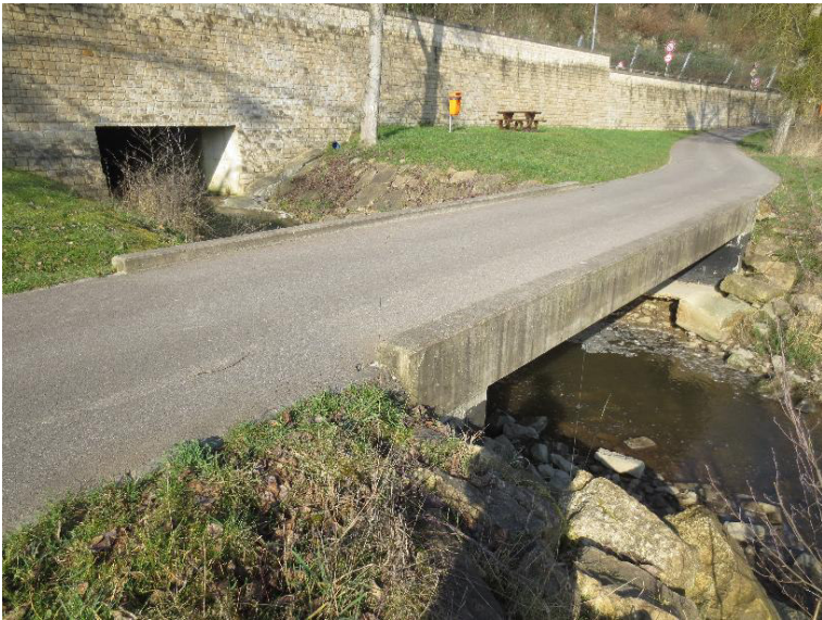
Durchlass; Ufer unterbrochen
