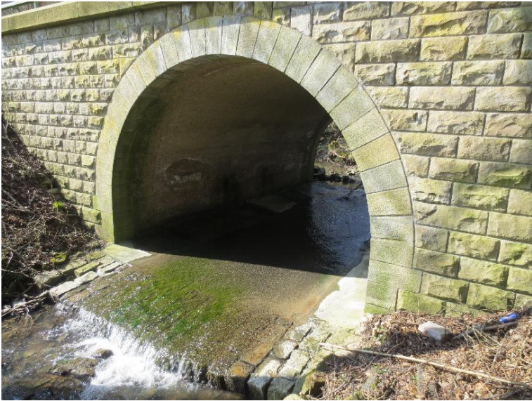
Durchlass; Ufer unterbrochen
