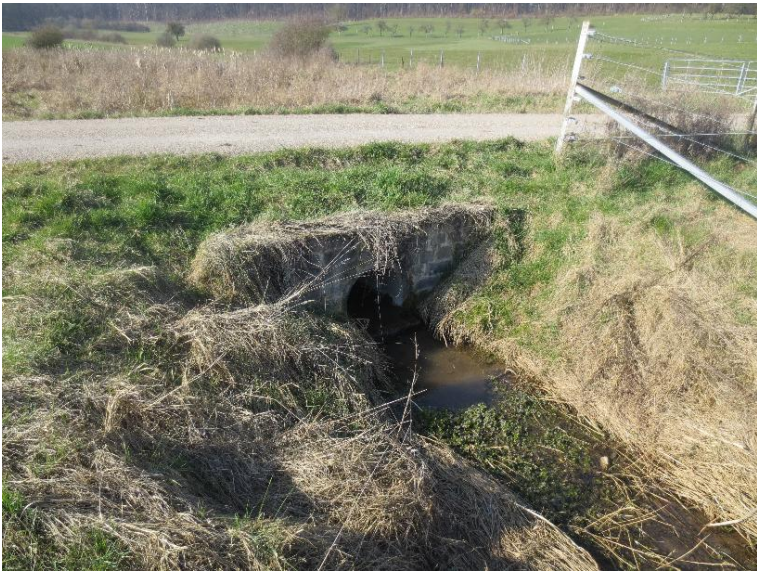
Durchlass; Ufer unterbrochen
