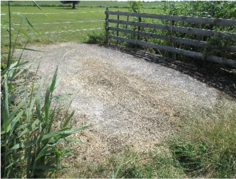
Durchlass; Ufer unterbrochen
