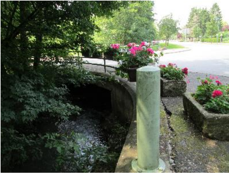
Durchlass; Ufer unterbrochen
