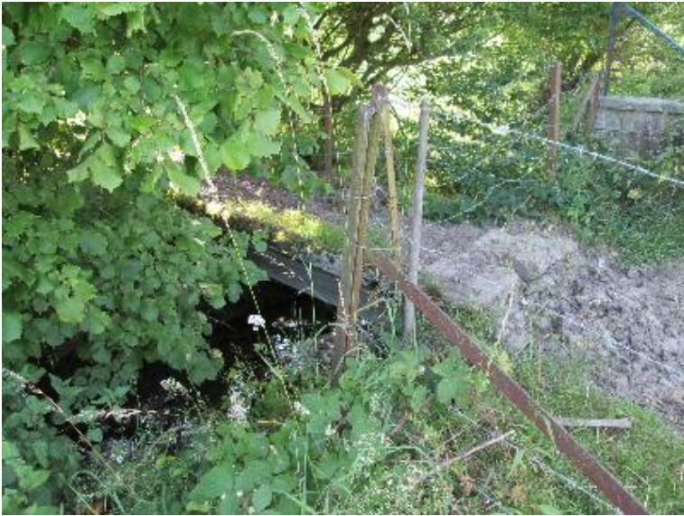
Durchlass; Ufer unterbrochen
