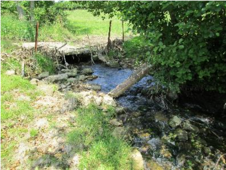
Raue Rampe - Durchlass; Ufer unterbrochen
