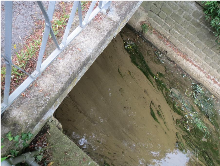
Durchlass; Ufer unterbrochen
