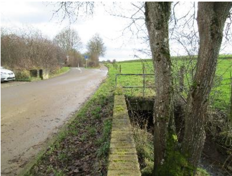
verrohrt bzw. ueberdeckt
