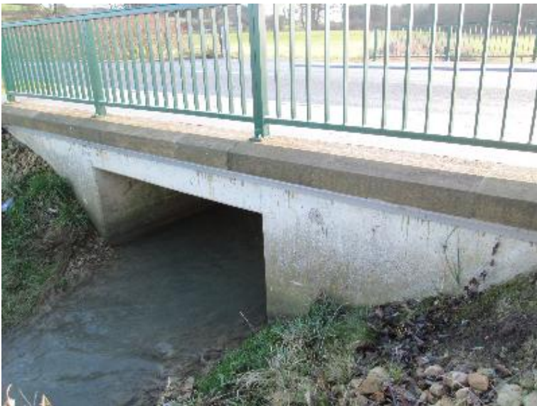
Durchlass; Ufer unterbrochen
