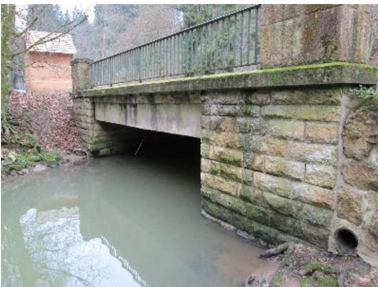
Durchlass; Ufer unterbrochen
