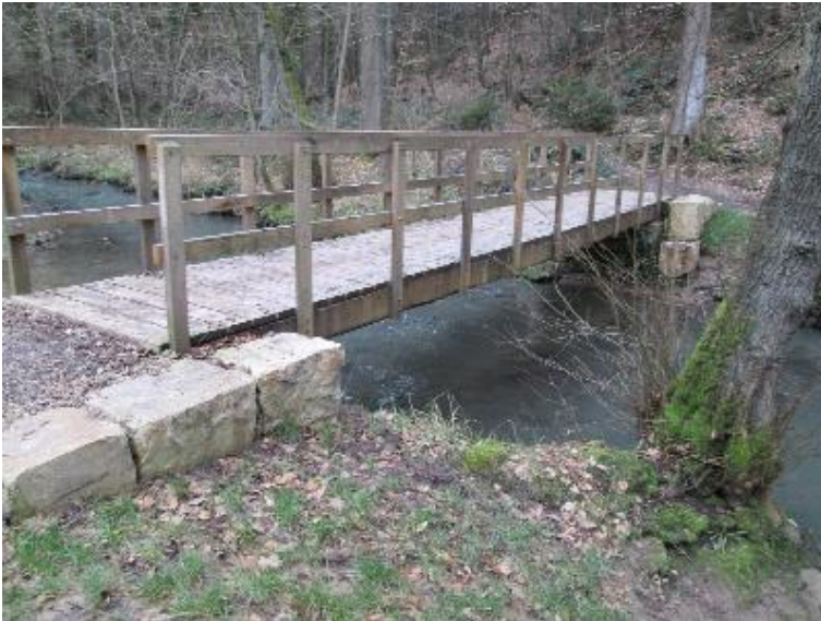
Durchlass; Ufer unterbrochen
