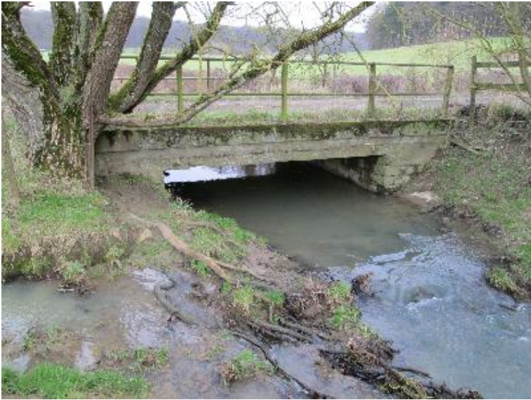
Durchlass; Ufer unterbrochen
