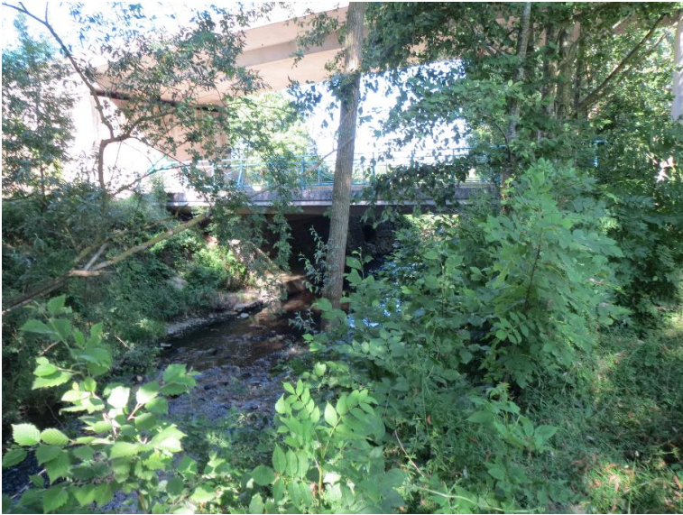
Durchlass; Ufer unterbrochen
