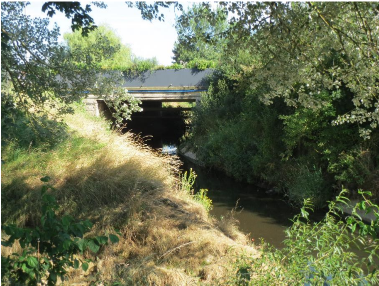
Durchlass; Ufer unterbrochen
