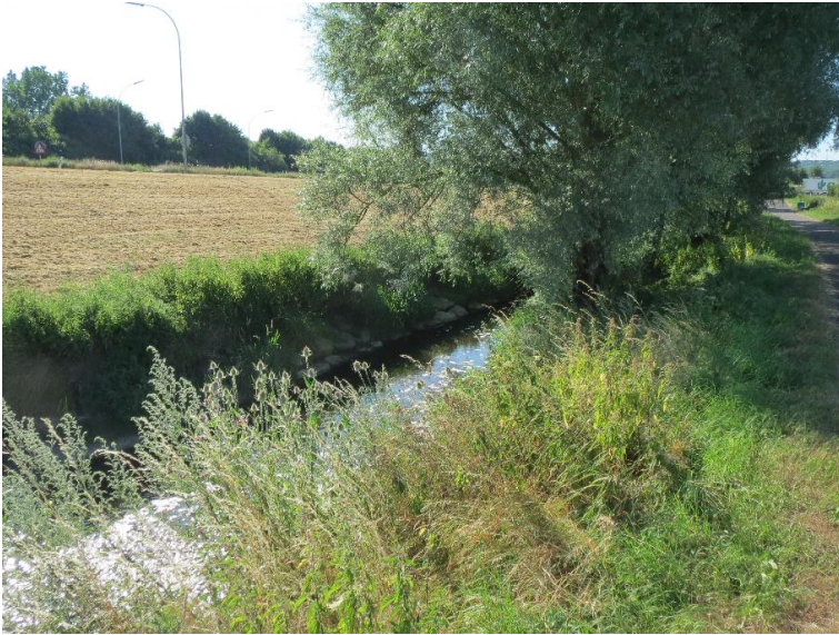
Uferverbau Steinschüttung
