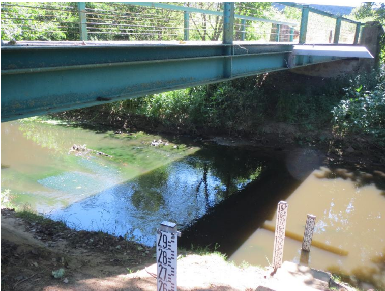
Durchlass; Ufer unterbrochen
