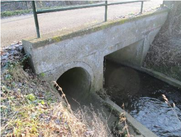
Durchlass; Ufer unterbrochen - Einleitung
