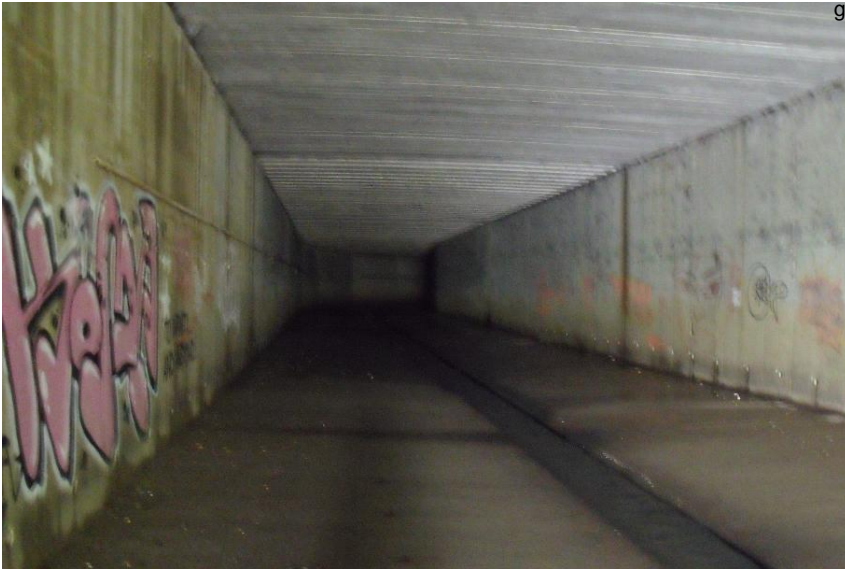
verrohrt bzw. ueberdeckt
