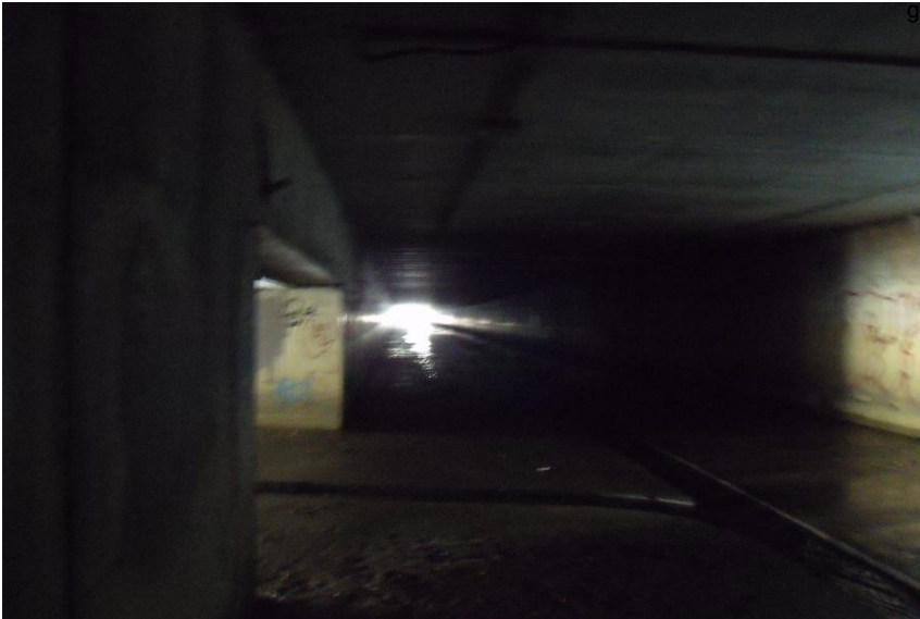
verrohrt bzw. ueberdeckt
