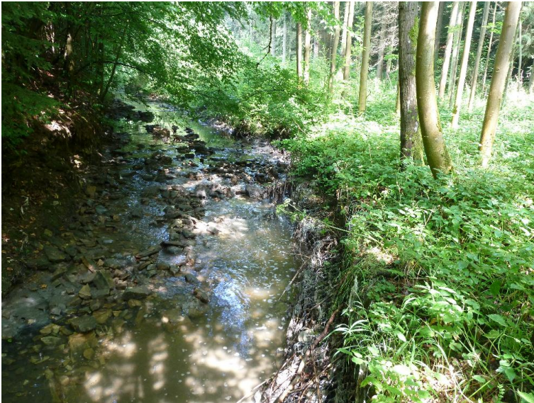
Uferverbau Steinsatz unverfugt - Ufersicherung
