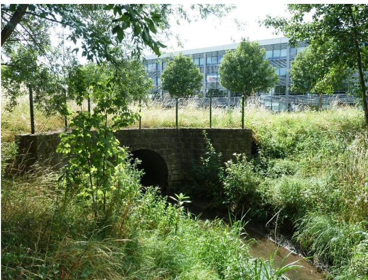
verrohrt bzw. ueberdeckt
