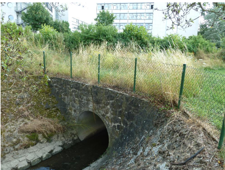
verrohrt bzw. ueberdeckt
