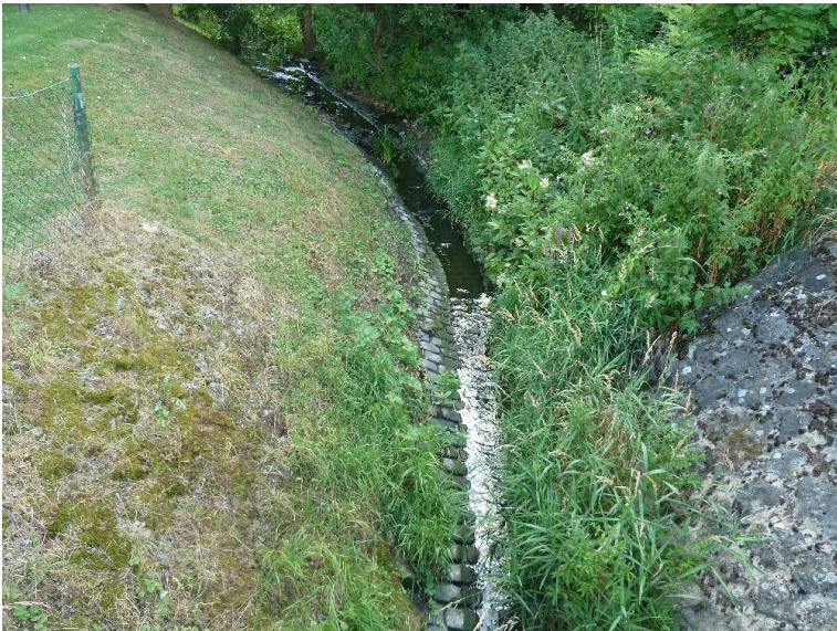
Sohlenverbau - Krautflur, Hochstauden
