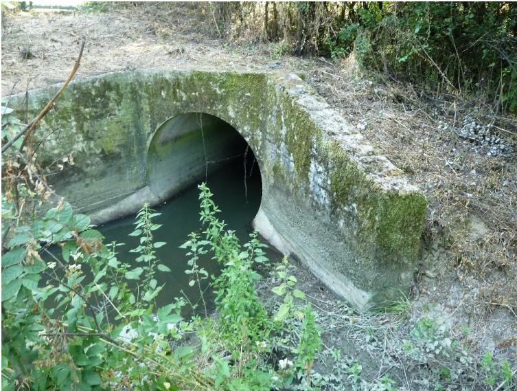
verrohrt bzw. ueberdeckt - Zulauf Nebengewaeser
