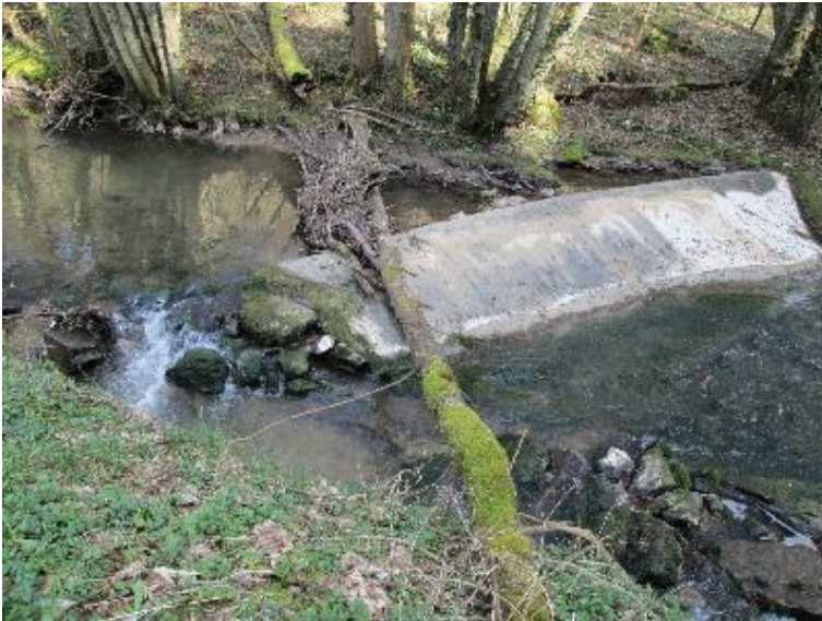
Raue Rampe mit Fischdurchlass
