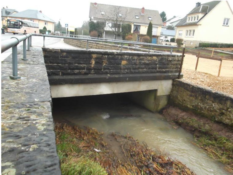
verrohrt bzw. ueberdeckt
