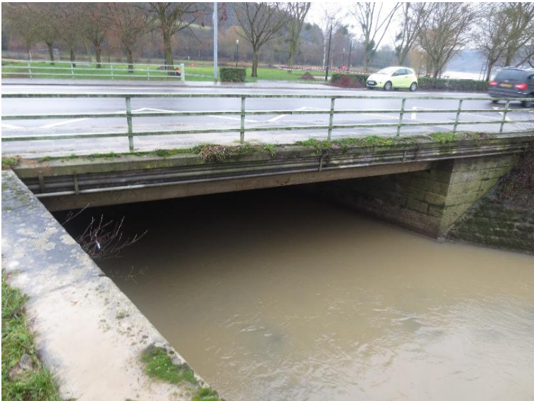
Durchlass; Ufer unterbrochen
