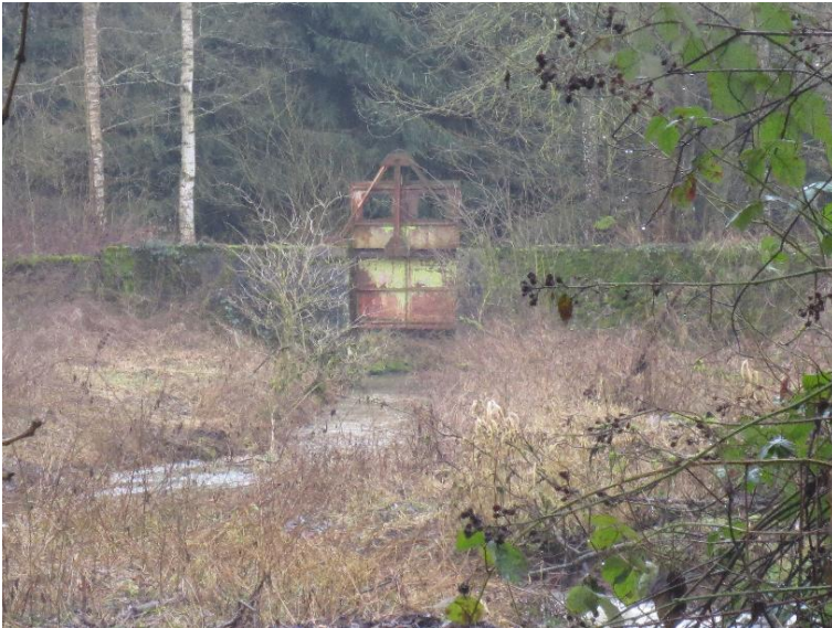
Durchlass; Ufer unterbrochen
