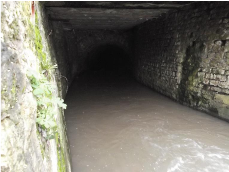
verrohrt bzw. ueberdeckt
