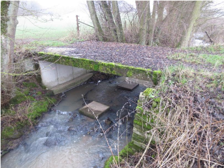
Durchlass; Ufer unterbrochen
