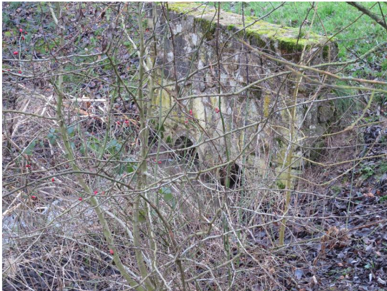
Durchlass; Ufer unterbrochen
