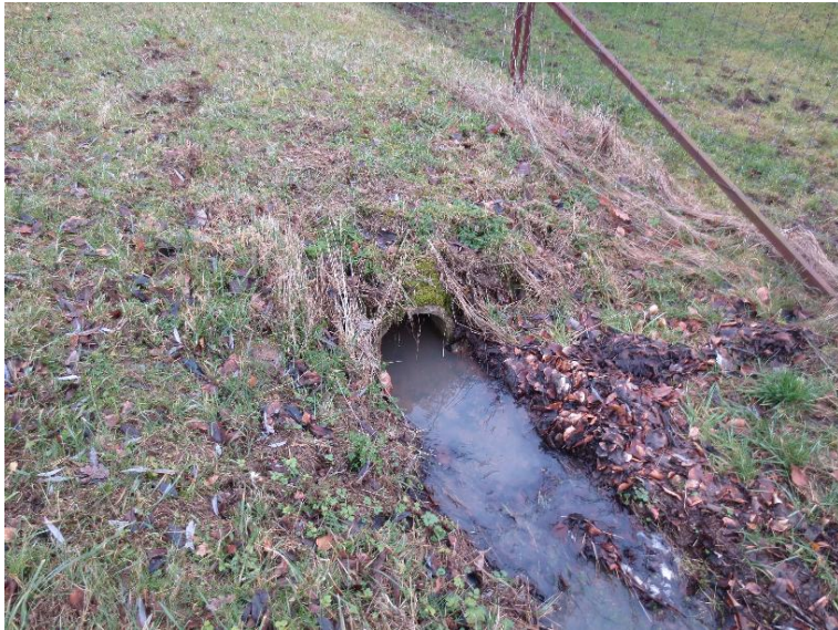
Durchlass; Ufer unterbrochen
