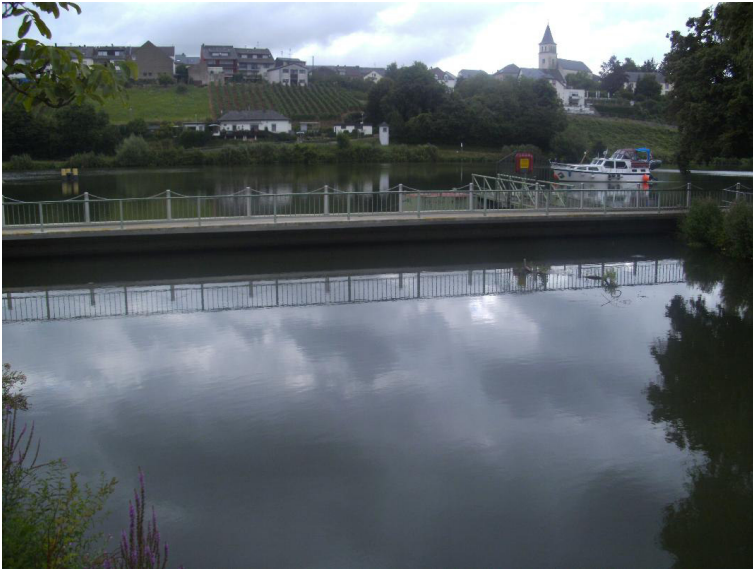
Durchlass; Ufer unterbrochen
