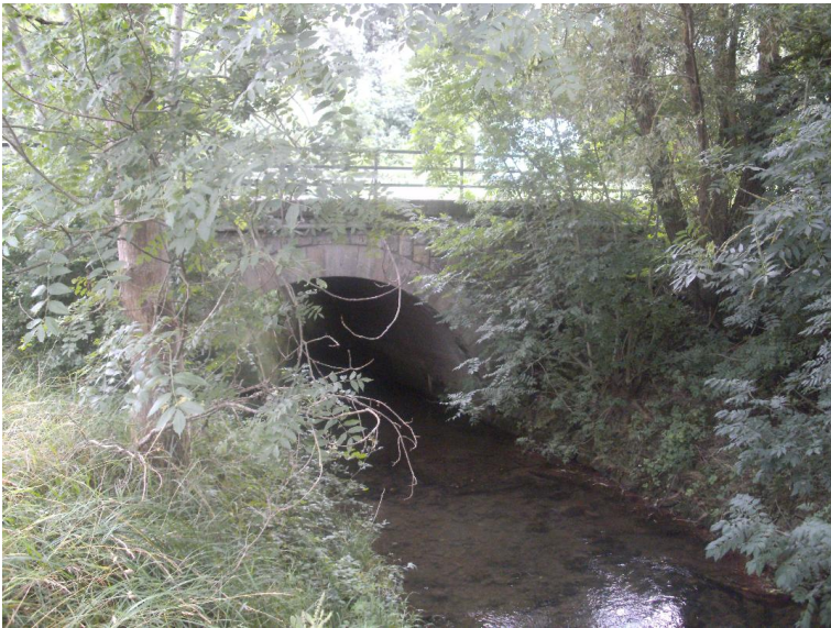
Durchlass; Ufer unterbrochen
