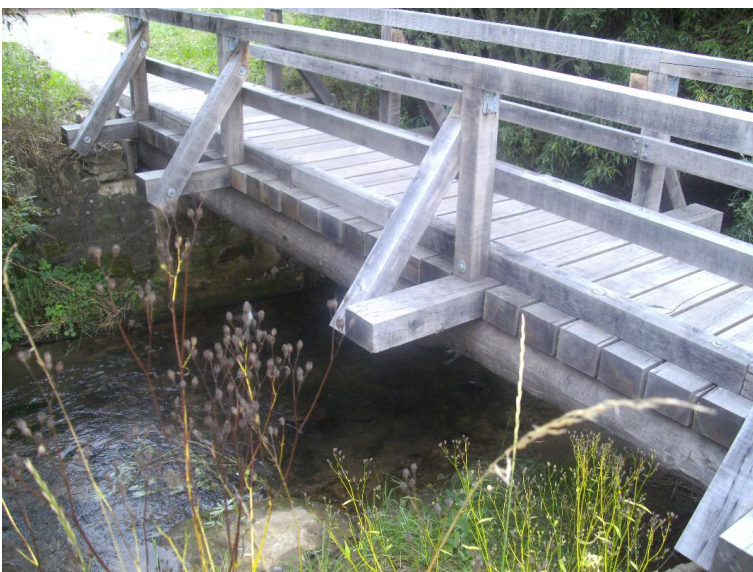
Durchlass; Ufer unterbrochen
