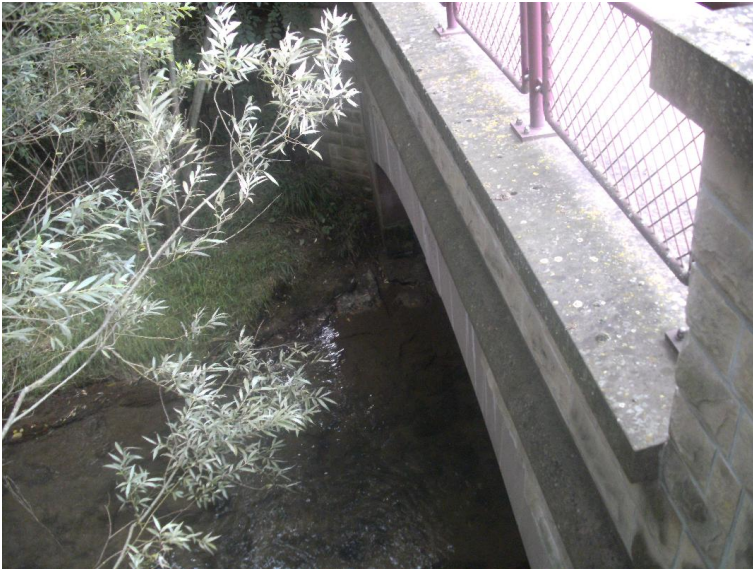
Durchlass; Ufer unterbrochen
