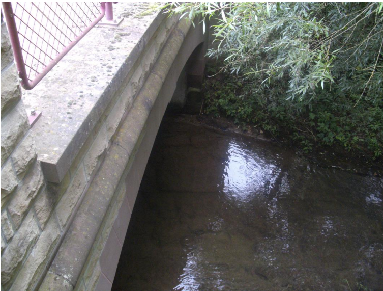
Durchlass; Ufer unterbrochen
