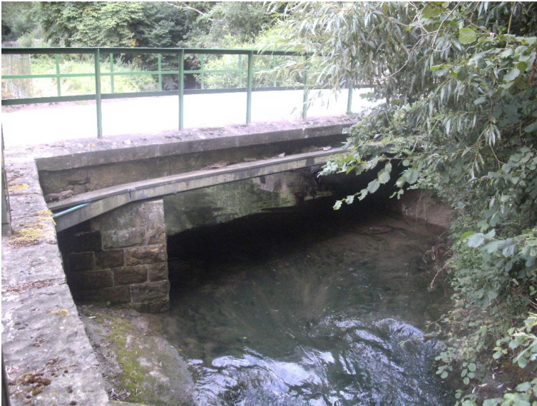
Durchlass; Ufer unterbrochen
