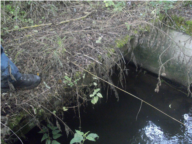
Durchlass; Ufer unterbrochen
