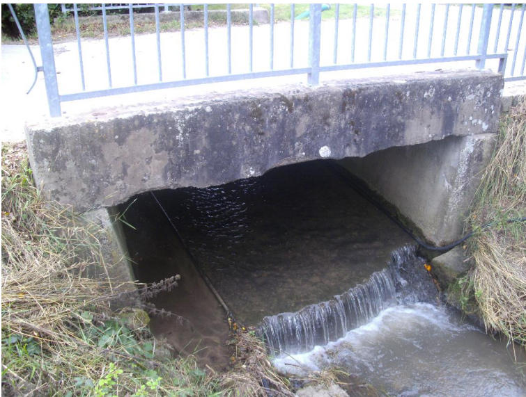
Durchlass; Ufer unterbrochen
