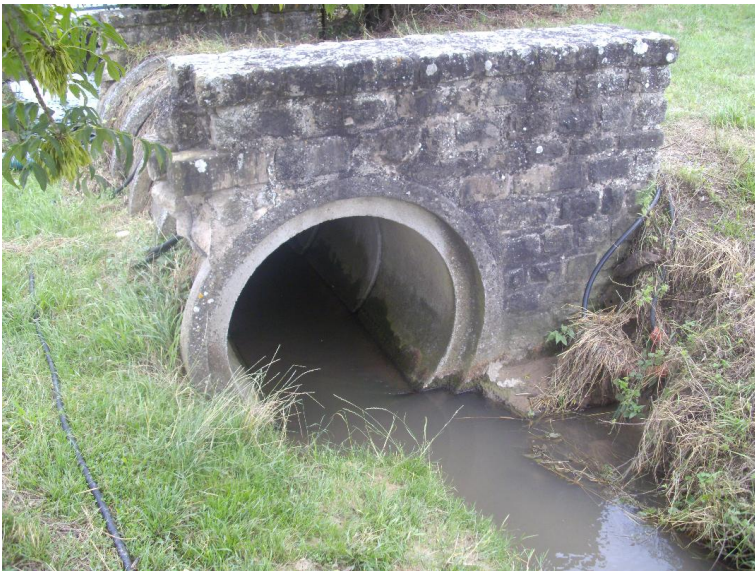
Durchlass; Ufer unterbrochen
