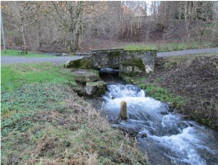
Raue Rampe - Durchlass; Lauf verengt
