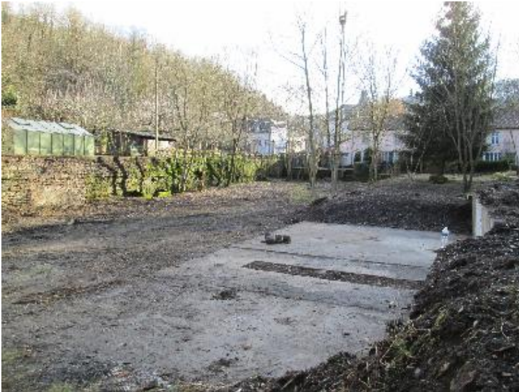
verrohrt bzw. ueberdeckt
